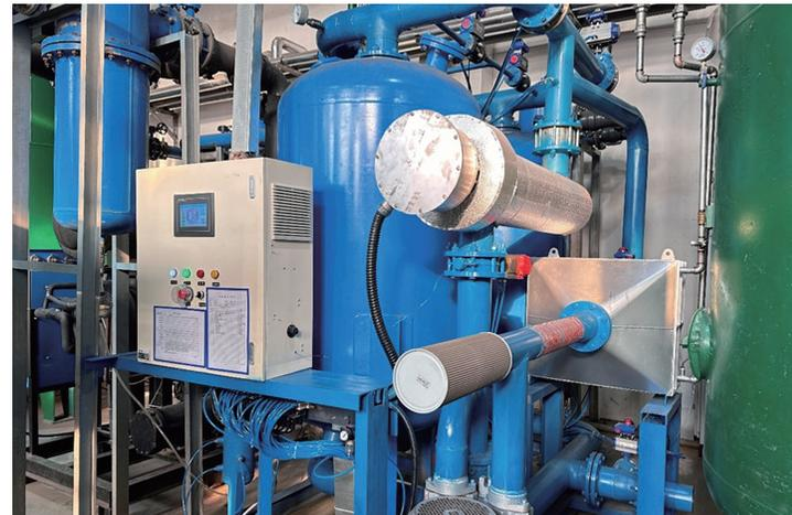
零气损鼓风机吸干机
