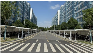
锦溪厂区全新避雨棚式停车场
